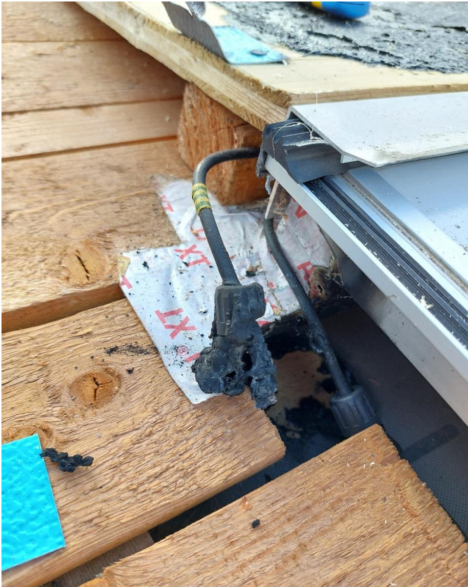
Abbildung 4.1: Defekte Steckverbindung Europa-Sport-Mittelschule
