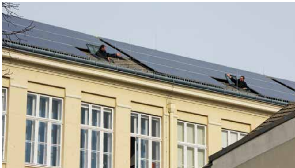
Vizebürgermeister Mag. Gerhard Wannemacher (r.) und Franz Rehberger inspizieren die Photovoltaik-Anlage am Dach der Volksschule Babenberggasse.
