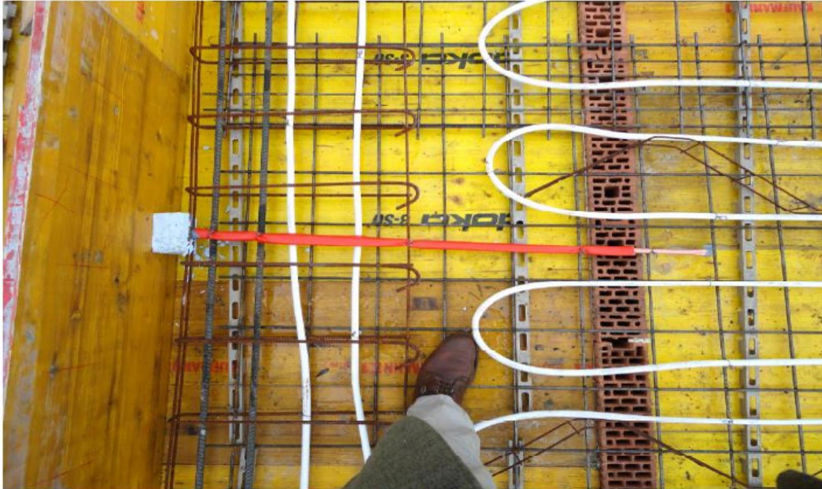
138 m<sup>2</sup> speziell für diesen Einsatzbereich konstruierte Gasokol Großflächenkollektoren in Verbindung mit Betonkern-Speichertechnologie zur vollsolaren Energieversorgung des [Veranstaltungszentrums](#)
