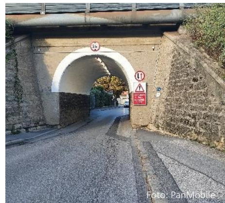
Bahndurchlass Südtiroler Gasse
