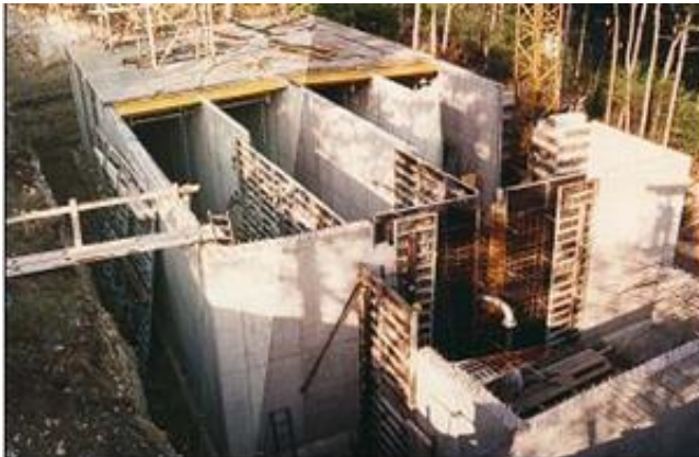
Bau der Hochbehälter im Prießnitztal
